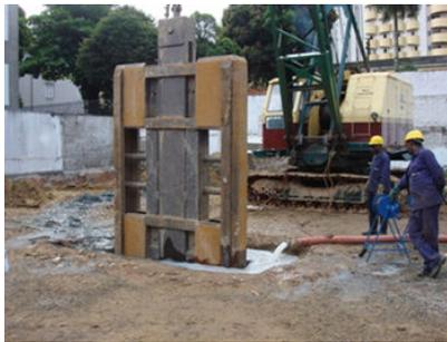
As lamelas da parede diafragma podem ser usadas individualmente para resistirem a elevadas cargas verticais. Neste caso são geralmente denominadas de estacas barrete.
