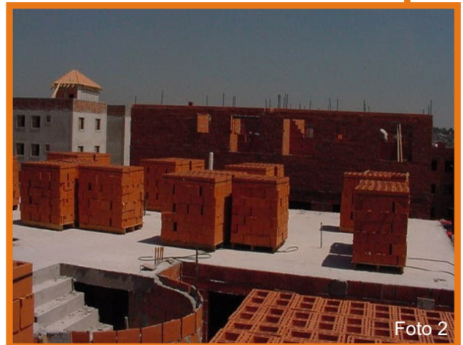
Fotos 1 e 2: Canteiro de obras de uma construção em alvenaria estrutural com blocos cerâmicos.
