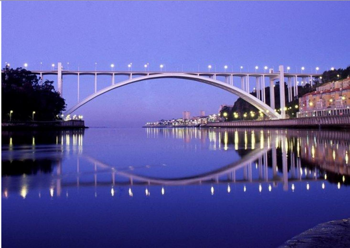
A ponte da *Arrábida*: o arco tangencia o tabuleiro da ponte.
