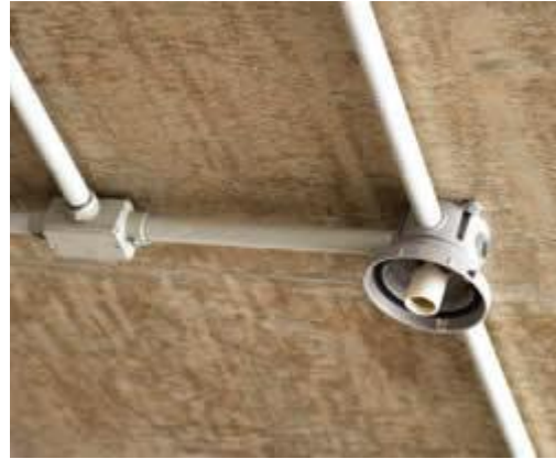
Eletrodutos instalados
