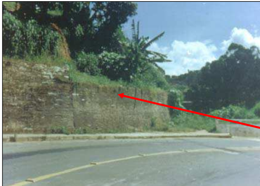
muro em solo-cimento - bairro de N. S. de Lurdes (J. Fora)
