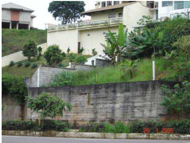
muro em concreto ciclópico - bairro Aeroporto (J. Fora)
