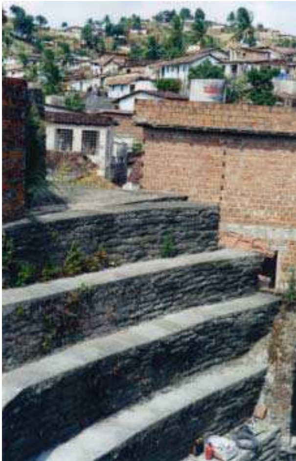
muro em solo-cimento
