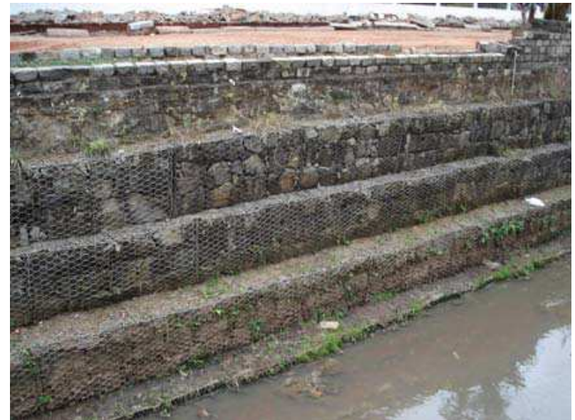
muro em pedras arrumadas manualmente em gaiolas metálicas – gabiões
