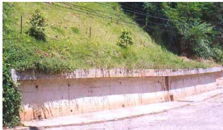
muro em L com contrafortes
