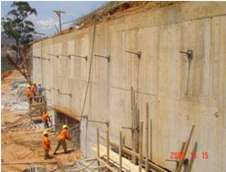
muro em cortina atirantada
