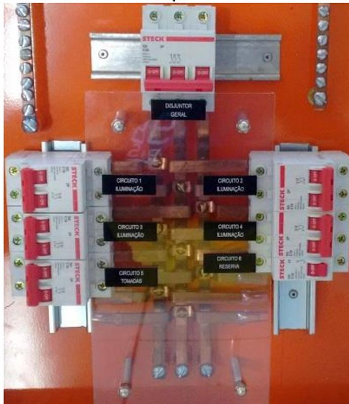
**Figura 46:** Placa de proteção de acrílico instalada no quadro elétrico, disponível em: <http://www.diariodoeletricista.com.br/2016/04/05/e-requisito-utilizar-acrilico-policarbonato-na-norma-5410/>, acesso em 22/11/2016.
