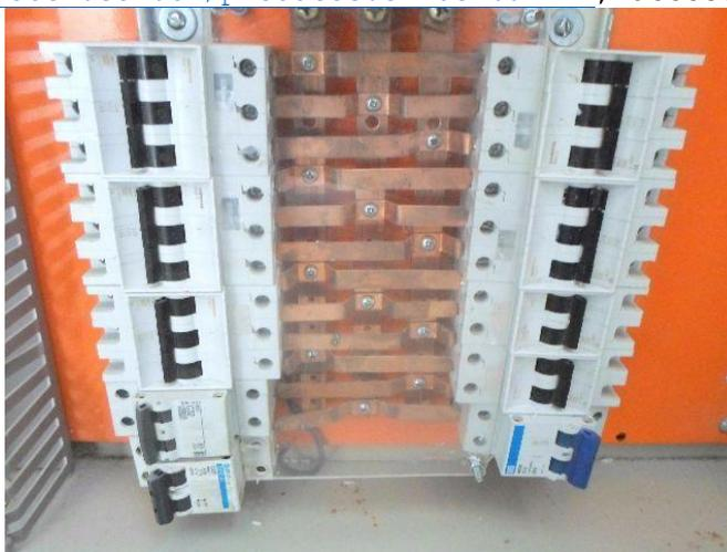
**Figura 45:** Barramentos protegidos com placa de acrílico, disponível em: <http://ce.olx.com.br/fortaleza-e-regiao/servicos/protecao-de-acrilico-para-quadros-eletricos-e-botoes-123697694>, acesso em 22/11/2016.
