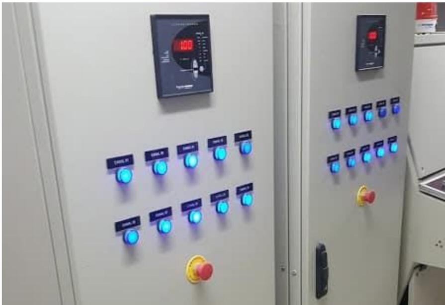
**Figura 31:** Painel com controlador automático de fator de potência e indicação visual do conjunto de células ativas, disponível em: [http://stelc.net/thw\\_industrial/correcao-de-fator-potencia/](http://stelc.net/thw_industrial/correcao-de-fator-potencia/), acesso em 13/11/2016.
