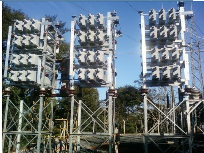
**Figura 27:** Banco de capacitores para sistemas de distribuição de energia elétrica, disponível em: [http://www.inepar.com.br/not\\_capacitores\\_eletropaulo.htm](http://www.inepar.com.br/not_capacitores_eletropaulo.htm), acesso em 13/11/2016.
