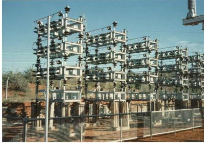
**Figura 26:** Banco de capacitores instalado em subestação de distribuição, disponível em: <http://www.ebah.com.br/content/ABAAAA5QcAG/banco-capacitores>, acesso em 13/11/2016.
