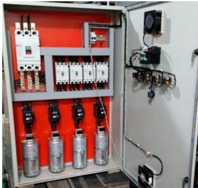
**Figura 29:** Células capacitivas instaladas em painel, disponível em: <http://www.inducap.com.br/bancos-de-capacitores>, acesso em 13/11/2016.
