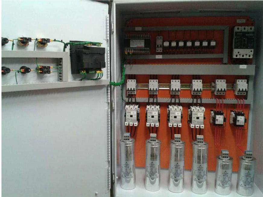
**Figura 30:** Exemplo de banco de capacitores instalados em um painel elétrico, disponível em: <http://www.mabitec.com.br/banco-capacitores-preco>, acesso em 13/11/2016.
